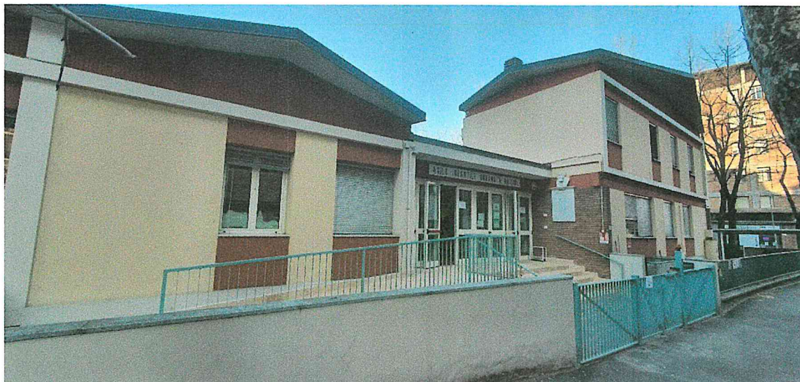
Foto 1 – facciata, via Bonacini 195/A
