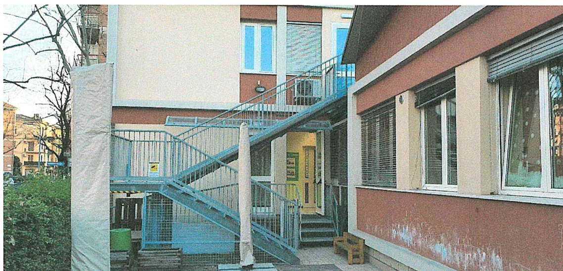
Foto 14 – scala di accesso alla copertura
