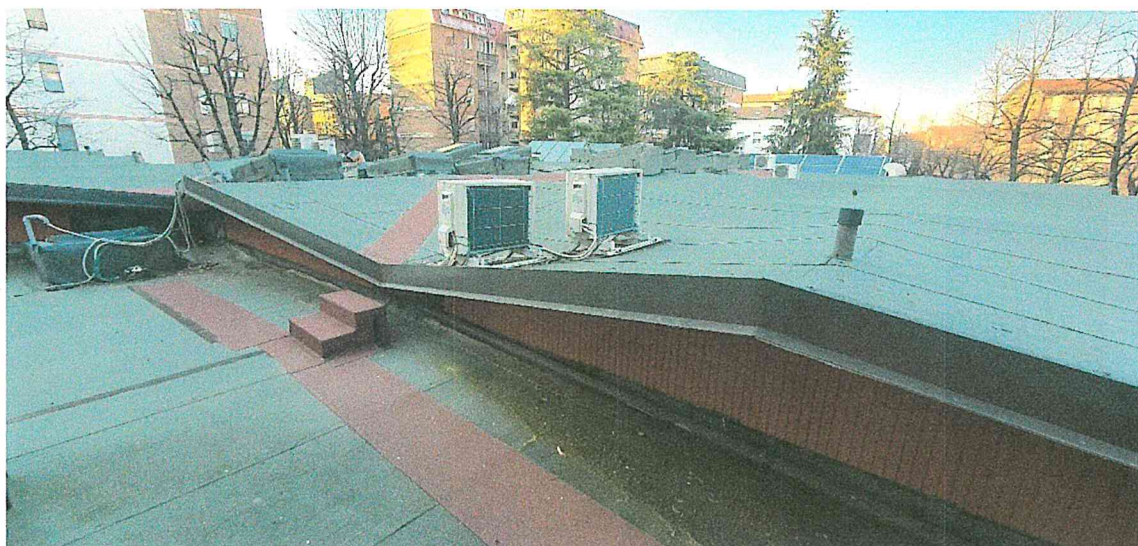
Foto 16 – percorsi per le manutenzioni in copertura
