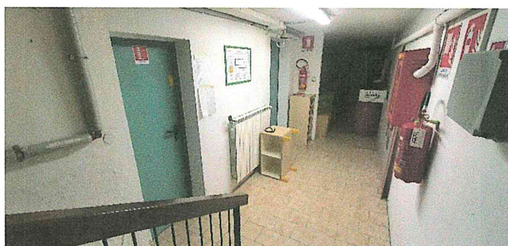
Foto 18 – locali di servizio al piano seminterrato
